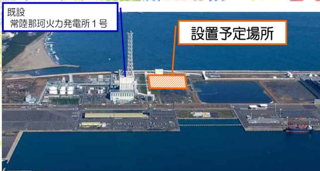
↑ 茨城県にある常陸那珂火力発電所 緊急設置電源 新設へ
